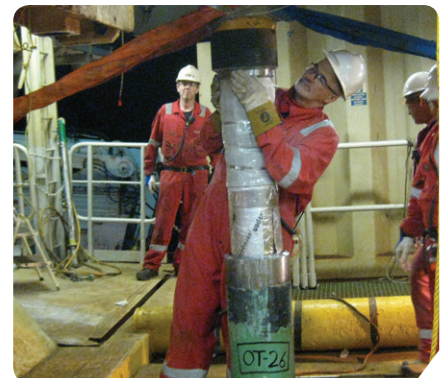
Welding ILS to pipeline
